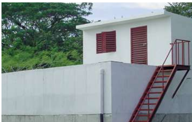
Planta de Tratamiento de Aguas Residuales Sanitarias.
