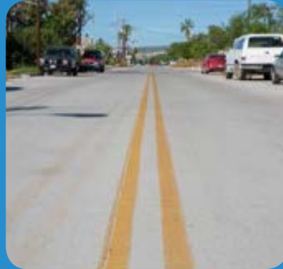
Pavimento de concreto
