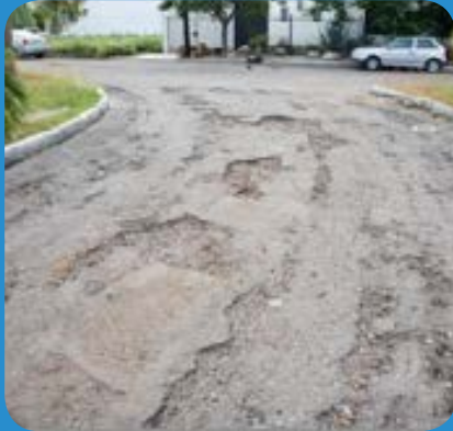
Pavimento de asfalto
